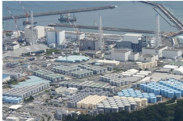
Các bể chứa nước thải nhiễm xạ tại Nhà máy Điện hạt nhân Fukushima Daiichi ở tỉnh Fukushima, Đông Bắc Nhật Bản
