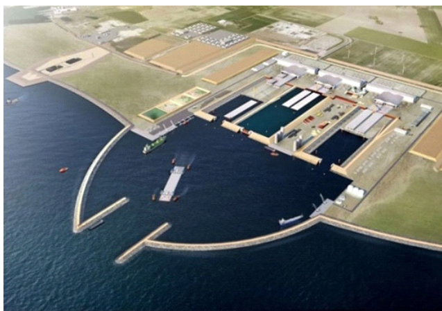
Nhà máy bên phía Đan Mạch sẽ lắp ráp 89 đoạn đường hầm
