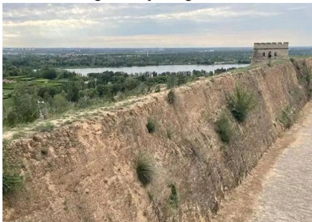
Một đoạn xây bằng vữa sống của Vạn Lý Trường Thành
