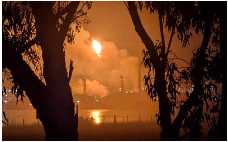
Cháy lớn tại nhà máy lọc dầu Viva ở Geelong, Australia, ngày 16/4/2026
