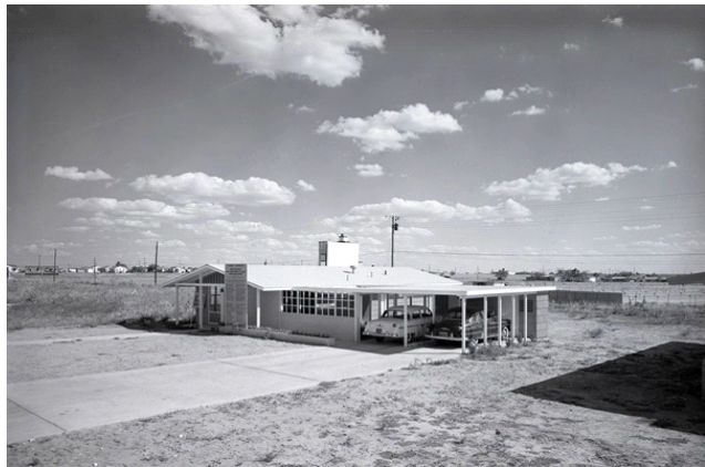
Một trong những ngôi nhà đầu tiên được lắp điều hòa ở Allandale, Texas
