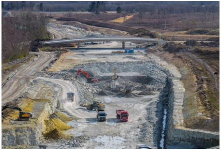
Công trình xây dựng đường sắt Baltica tại Estonia
